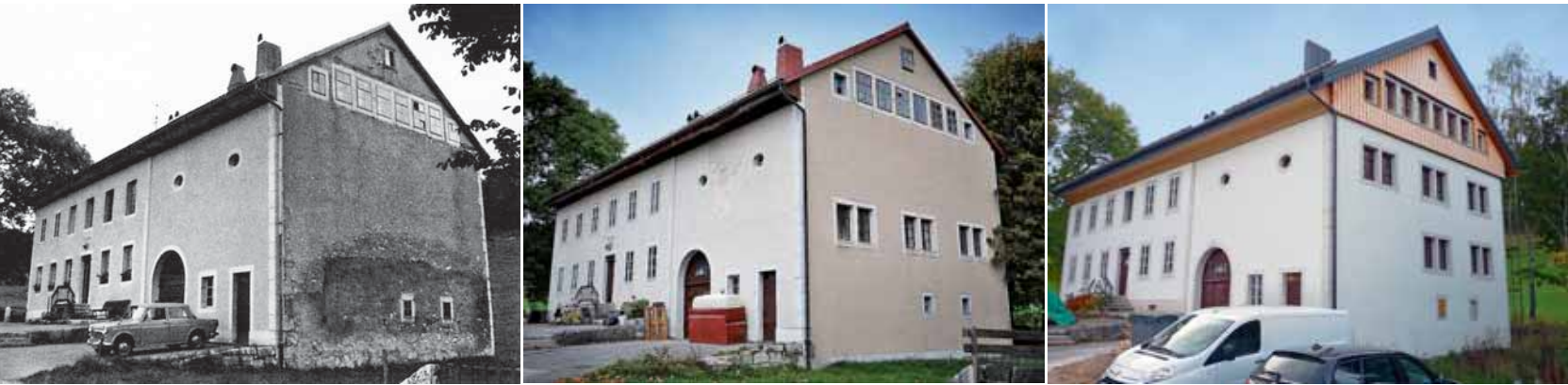
Das Haus Grand Pièce in Solliat in den 50er-Jahren, dann im Jahr 2000 und 2012. Hinter den Glasfenstern des Ateliers, das 1855 gegründet wurde, sind heute wieder Uhrmacher am Werk.
