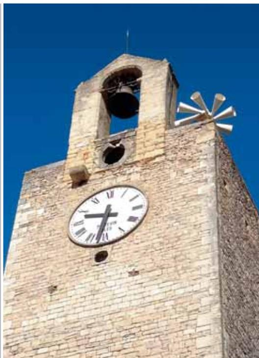
Au sommet d'un beffroi, une grappe de haut-parleurs diffuse une sonnerie de cloches enregistrée et des carillons que ne peut offrir l'unique cloche du village. Et son rôle d'alarme est repris par la sirène.
